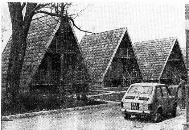
Fot. 35.2. Domki wczasowe w Łętowni OPGK w Krakowie
